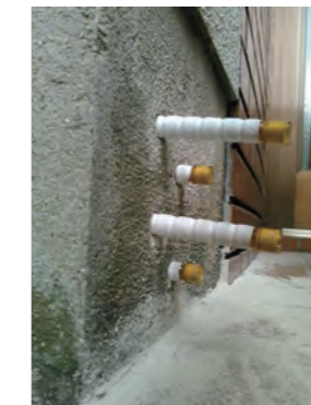
無筋の基礎の場合ケミカルアンカーを勧めます
