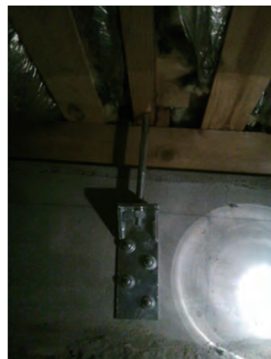
外部からの取り付けが無理な場合
