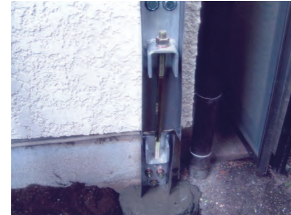
基礎が短い場合は、掘り込んで設置後、モルタルで補強
