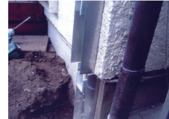
基礎が短い場合は、掘り込んで設置後、モルタルで補強
