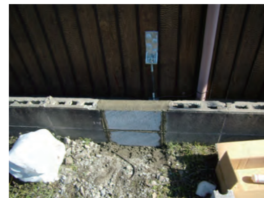
設置後新しいブロックを積みます
