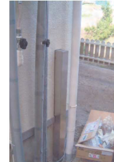
壁をカットして柱に直接付けました コーキング処理をしっかりとします
