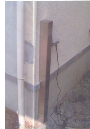
水切りをカットして付ける
