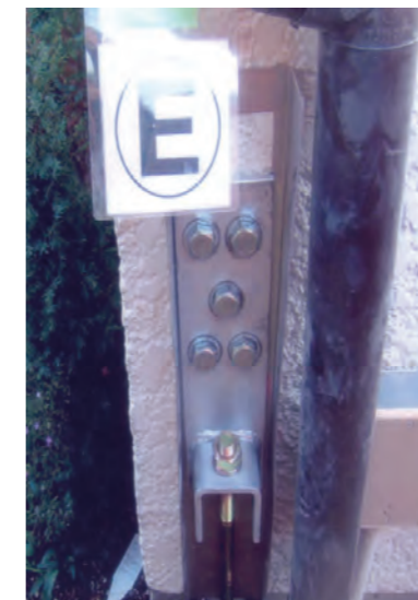
化粧カバーの受けとパワープレートを設置
