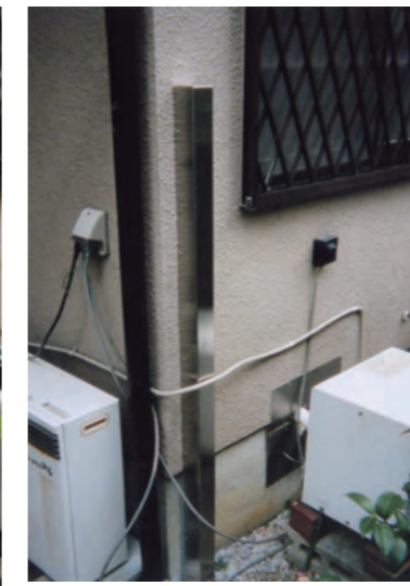
浴室外部の設置用長いテンションボルトと化粧カバー L:800mm L:1600mm
