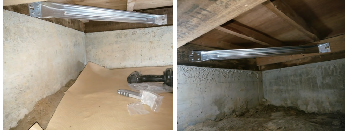
床下火打ち補強
