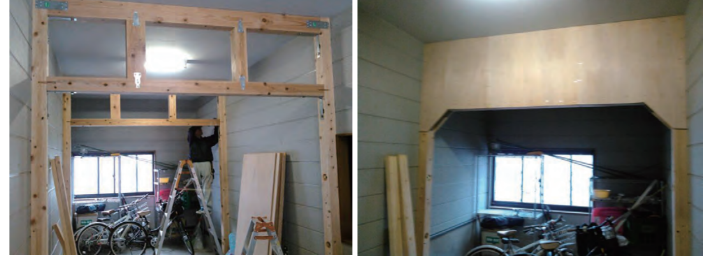
1階ガレージに補強壁をつくる
