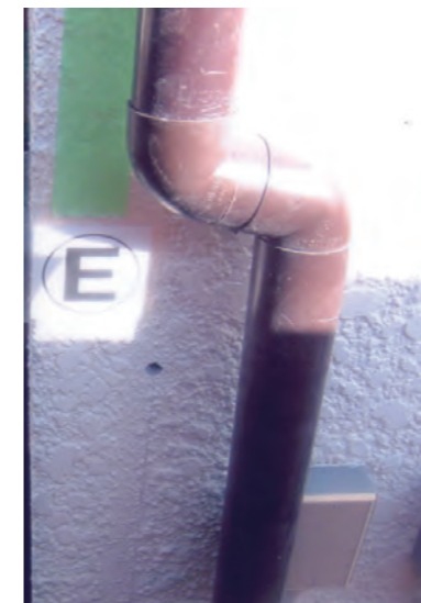
まず樋をかわして墨付け
